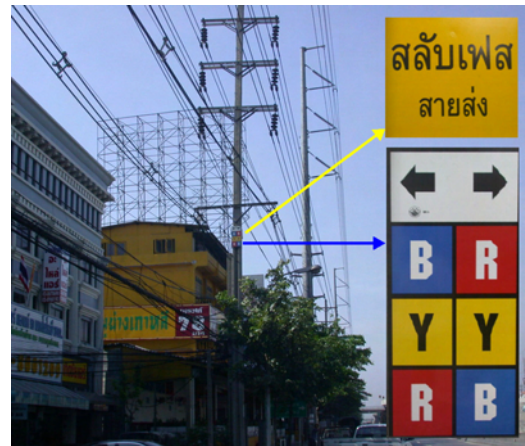
รูปที่ 10 การให้สัญลักษณ์สลับเฟสสายส่ง
