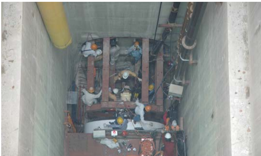
การก่อสร้างสายส่ง 230 เควี สถานีต้นทางบางกะปิ-สถานีต้นทางชิดลม
